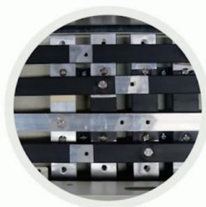
Barras aisladas con manga termocontráctil. (para evitar falsos contactos y cortos circuitos).
